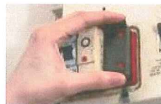
remplacer un fusible
